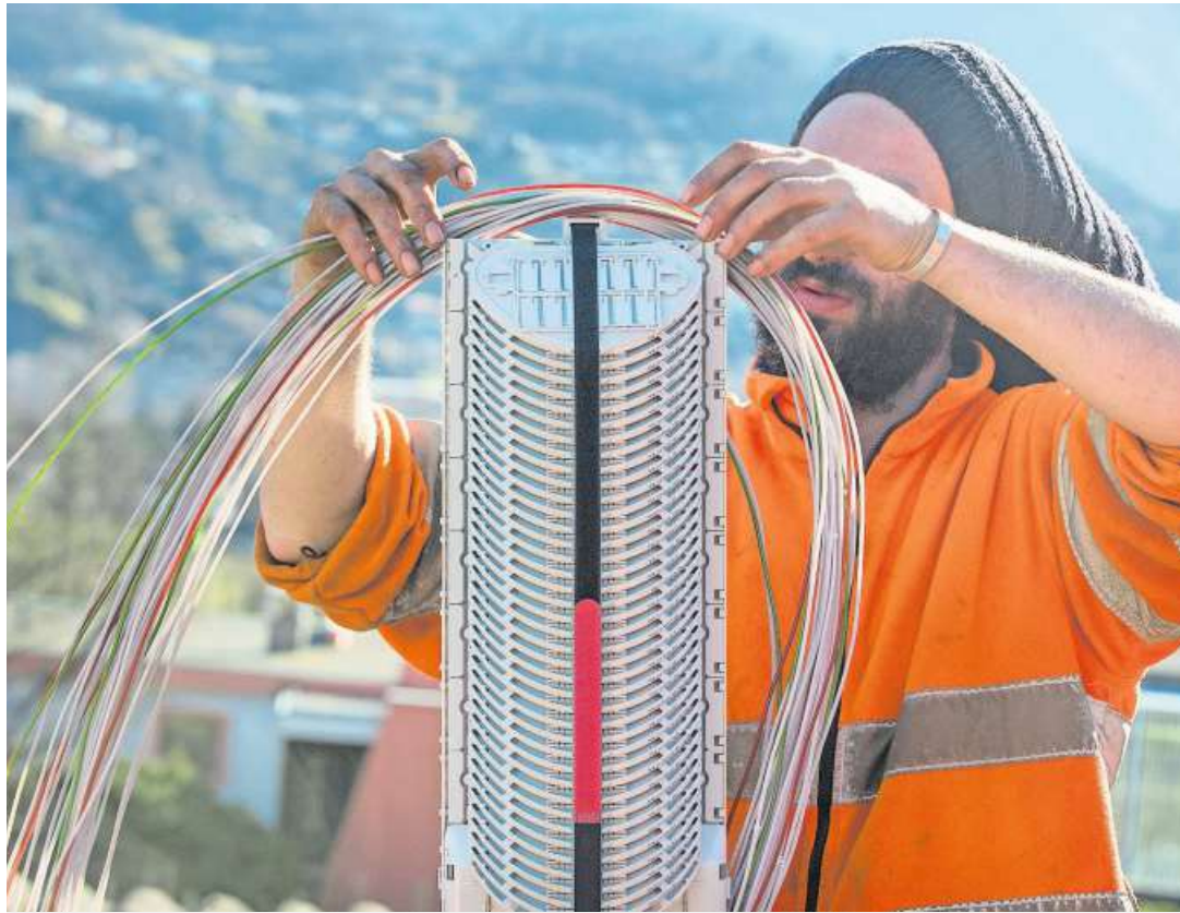
Ein Arbeiter montiert Glasfaserkabel für schnelleres Internet.
