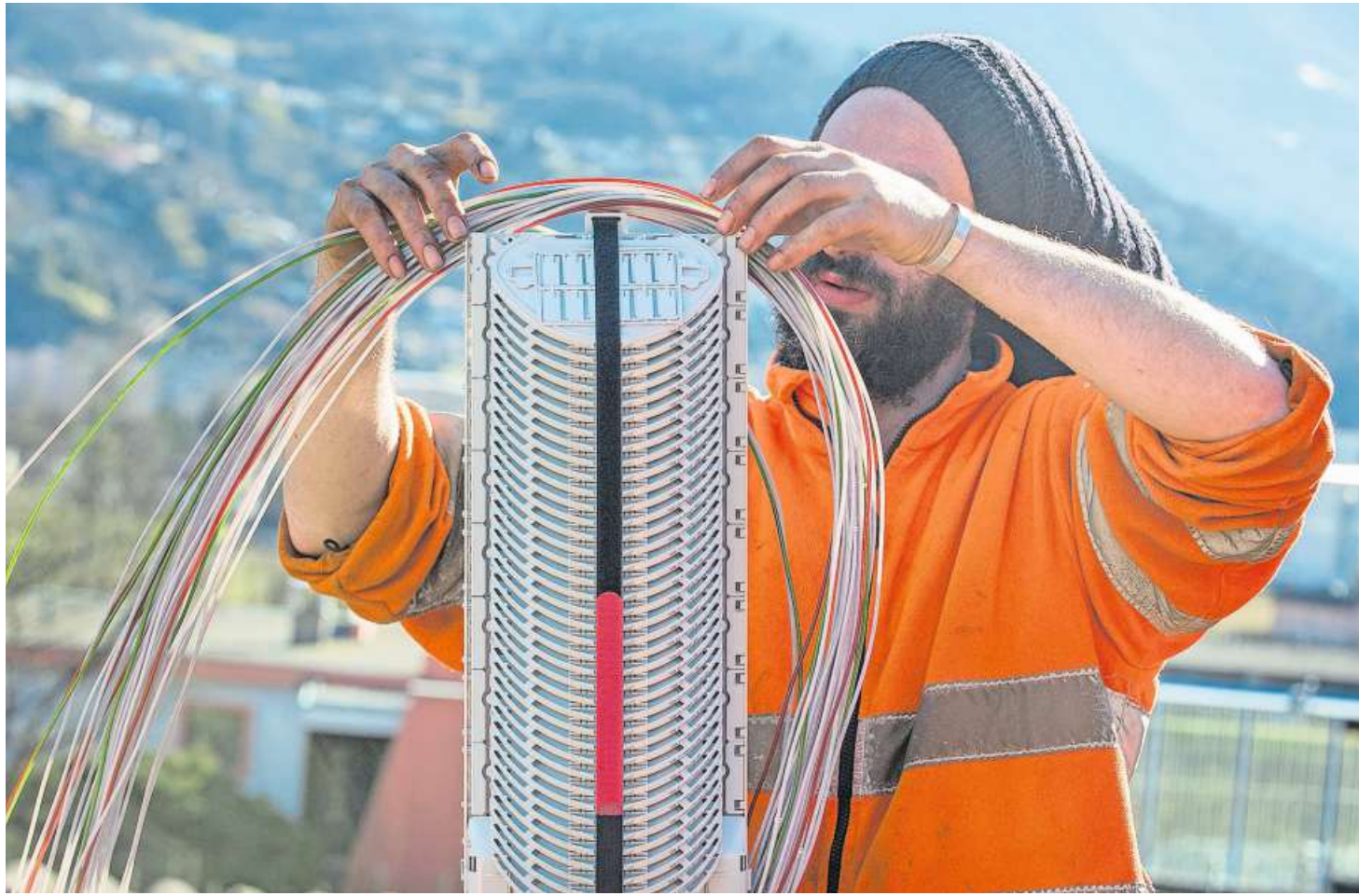
Ein Arbeiter montiert Glasfaserkabel der Swisscom für den Internetanschluss von Privathaushalten.
